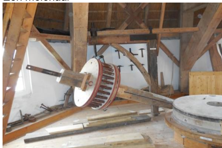
De steenspil met de beschadigde vloer
