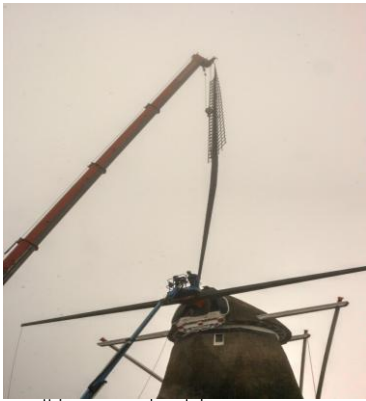
Het verwijderen van de wieken
